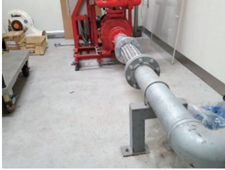
消火栓配管完成
